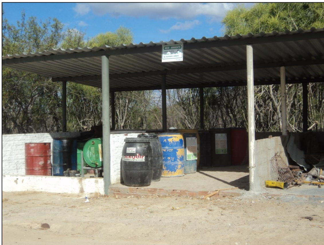
Figura 3.3.6.2- Tambores com óleo lubrificante usado (recipientes à esquerda) e tambor com resíduos contaminados que são enviados à Serquip (bombona de PEAD preta ao meio).
