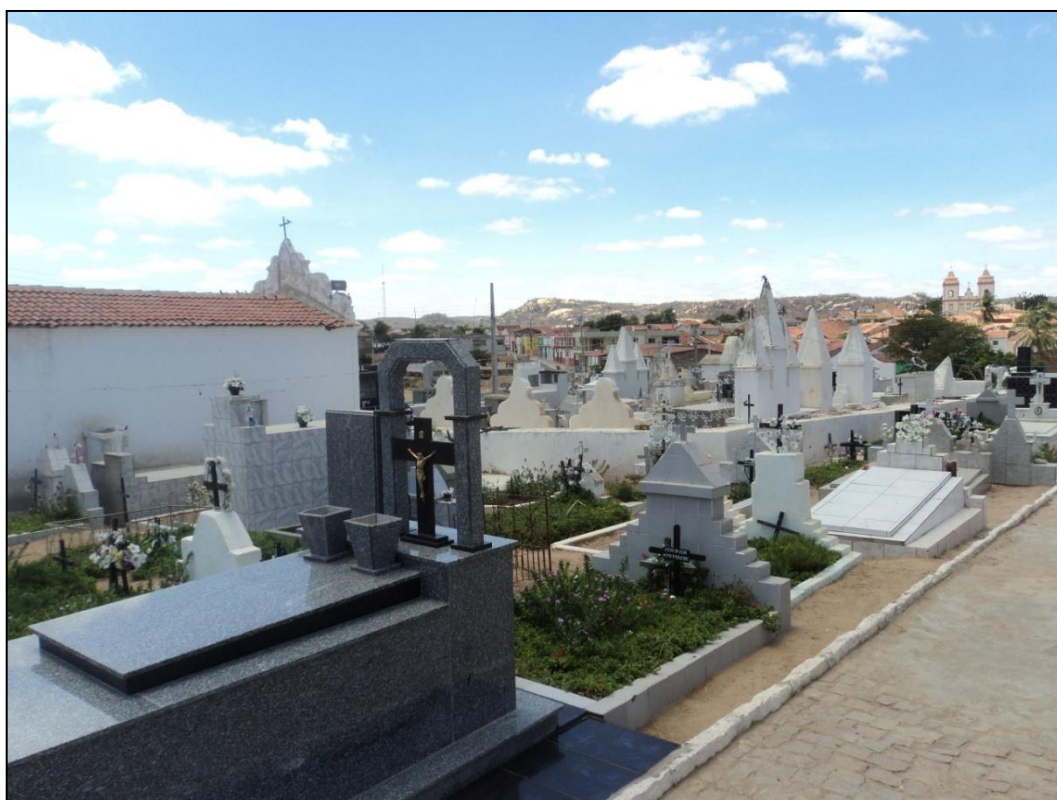
Figura3.3.7.4.1 – Cemitério Municipal de Pedra Lavrada.
