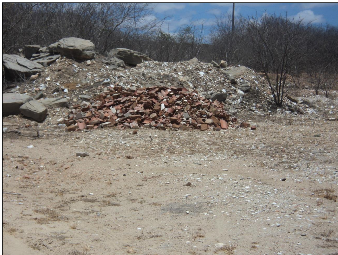
Figura 3.3.4.1 – Resíduo da construção civil em terreno baldio.
